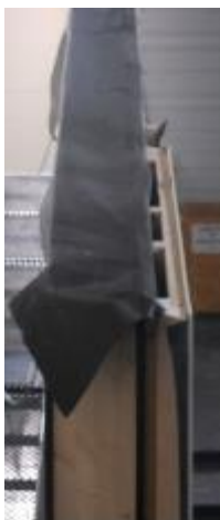
Figure 2 : Protection provisoire en tête de mur SYBOIS
