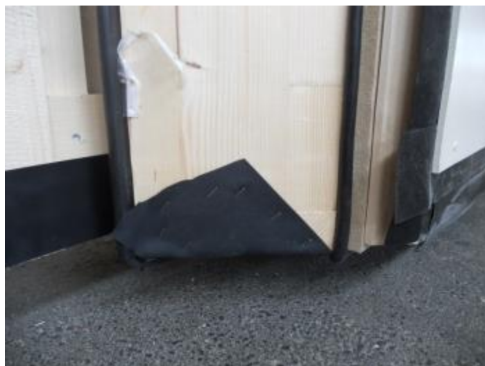
Figure 1 : Détail de relevé de la bande de protection en extrémité d'élément de mur SYBOIS (ici mur d'angle avec coupe à 45°)
